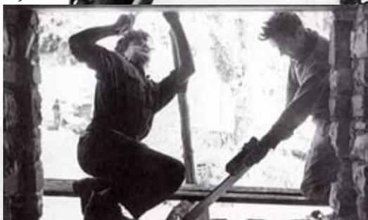
A mesure que le mur du fond s'élève, de gros blocs de rochers sont entassés afin qu'ils fassent corps avec la paroi. Travail considérable qui empêchera le mur d'être emporté en cas d'avalanche et permettra un meilleur écoulement de l'eau. ▲
